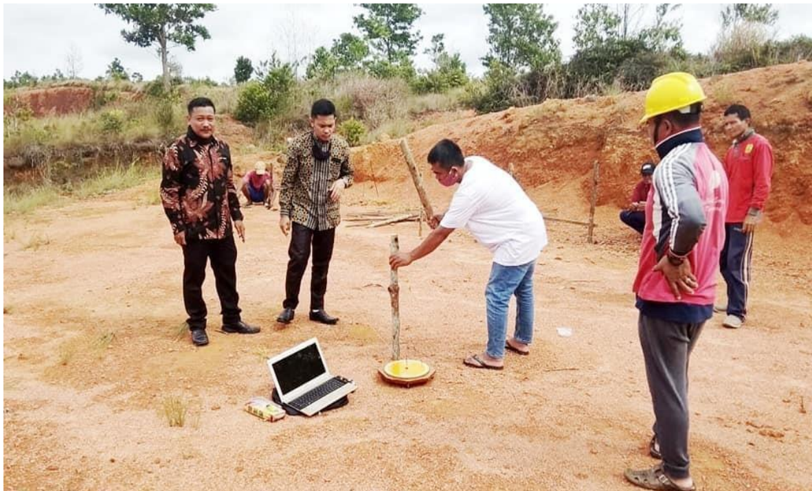
Gambar 4. Pemasangan tiang patokan arah kiblat Masjid Syaikh Zainuddin
